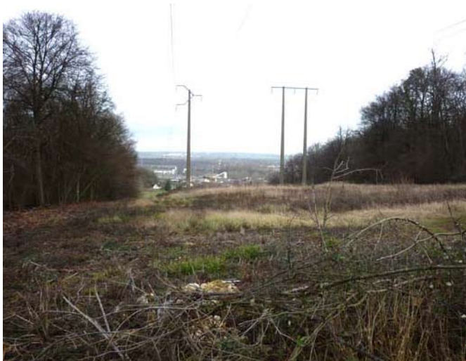
Comme l'autoroute, le passage du réseau électrique a laissé des marques prégnantes dans le paysage du coteau, entaillant sa couverture boisée.
