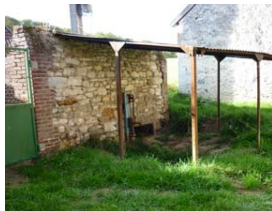
Lavoir asséché du Fond Maillet et sa pompe. Ce hameau était également alimenté par une fontaine située plus en amont en forêt et qui venait alimenter la mare au moyen d'une canalisation en grès réalisée en 1877.
