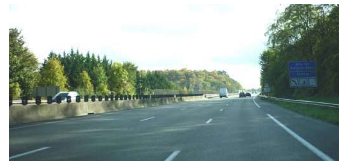
Le franchissement du Val du Rouanne reste un séquence assez étanche pour l'usager de l'infrastructure.
