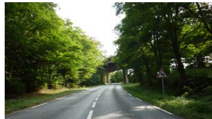
Superposition du réseau mise en scène par le franchissement du viaduc. Un itinéraire calé sur sol, la RD 100, un autre qui garde en mémoire la côte du plateau, l'autoroute.
