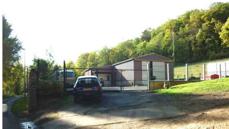
Local artisanal, au droit du viaduc.
