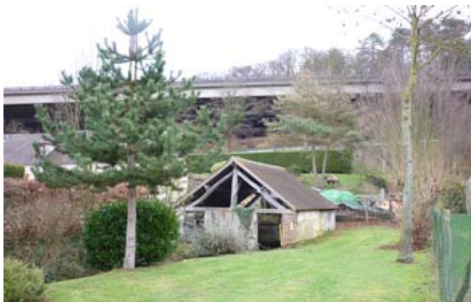
De nombreuses fontaines-lavoirs jalonnent les vallons. Ces points d'eau ont généré la construction d'édicule de protection qui signale la présence de l'eau (lavoir de Noël-Saint-Rémy).
