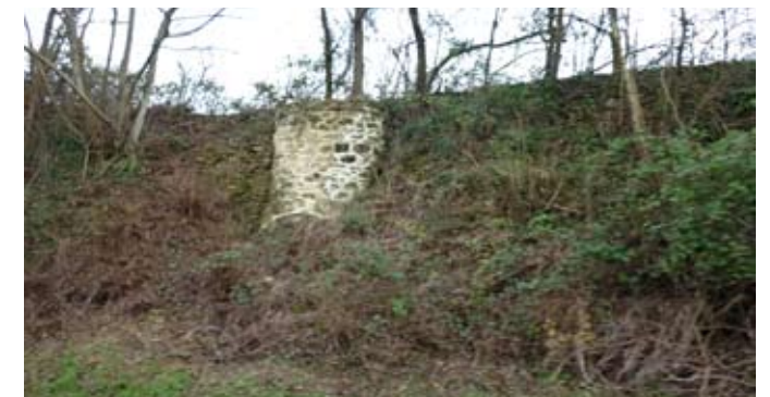
Autre trace de l'exploitation de la roche, le four à chaux, en bordure de la RD 100 (construit en 1919, restauré en 2005). Il était mis en charge depuis le rebord de plateau, ce qui explique sa position et bénéficié de l'accès par la route.
