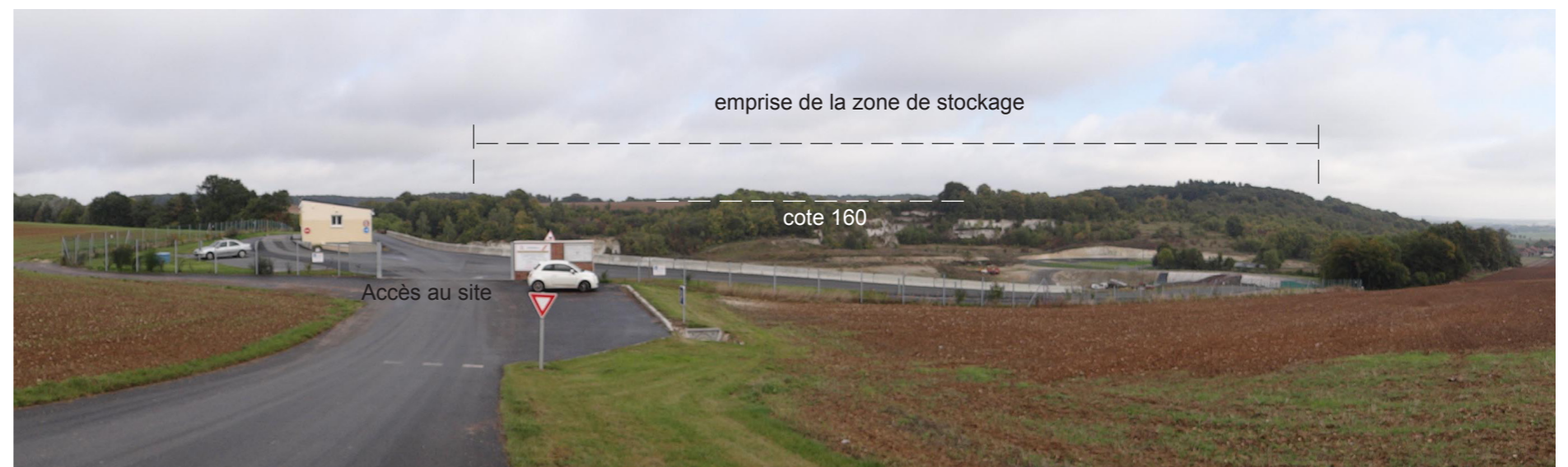
2 - Vue sur l'entrée actuelle du site.
