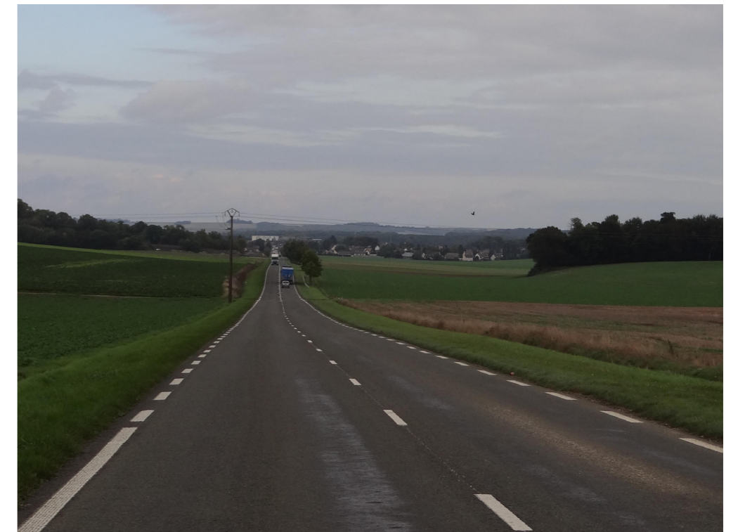
3 - Vue depuis la RD 930 en direction du centre de Breteuil niché en fond de vallée.
