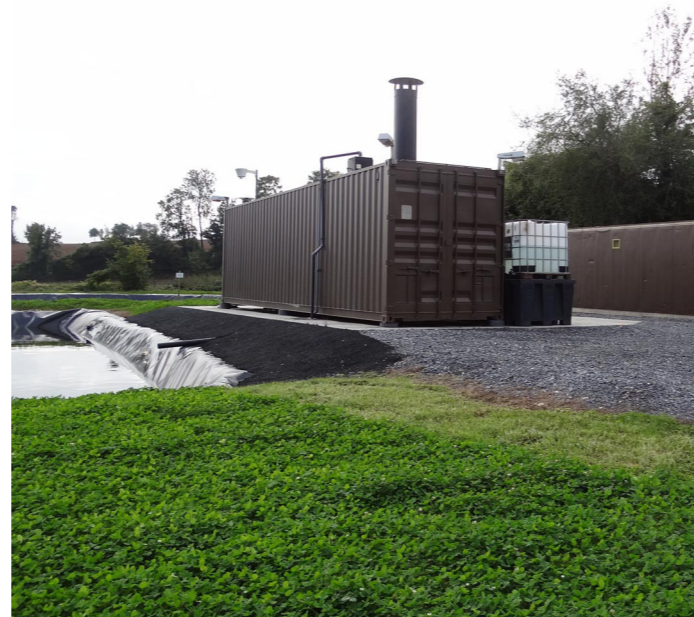
2 - Les bâtiments de la zone technique.
