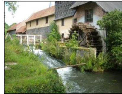
Figure 52 : moulin de Frémontiers sur les Evoissons
