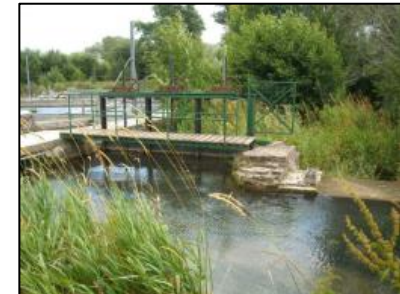
Figure 54 : vannage adjacent à la pisciculture de Famechon
