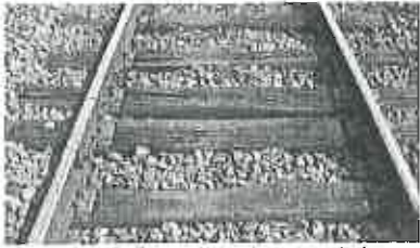
Rails courts sur traverses bois
