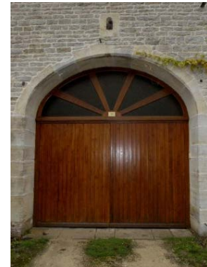
Porte pleine et imposte vitrée - Arc cintré
