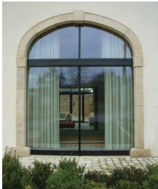
Porte vitrée - Arc cintré
