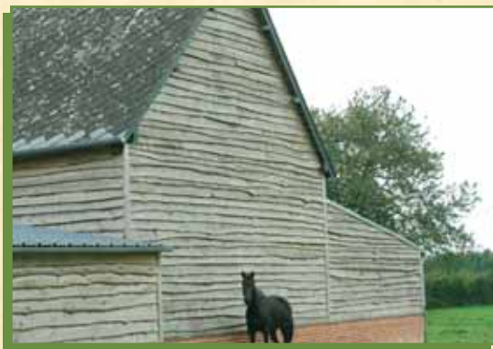
Bardage extérieur en aulne
