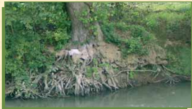
Le système racinaire des arbres stabilise les bords des berges
