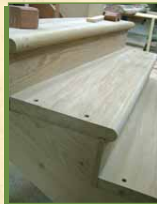
Escalier en frêne
