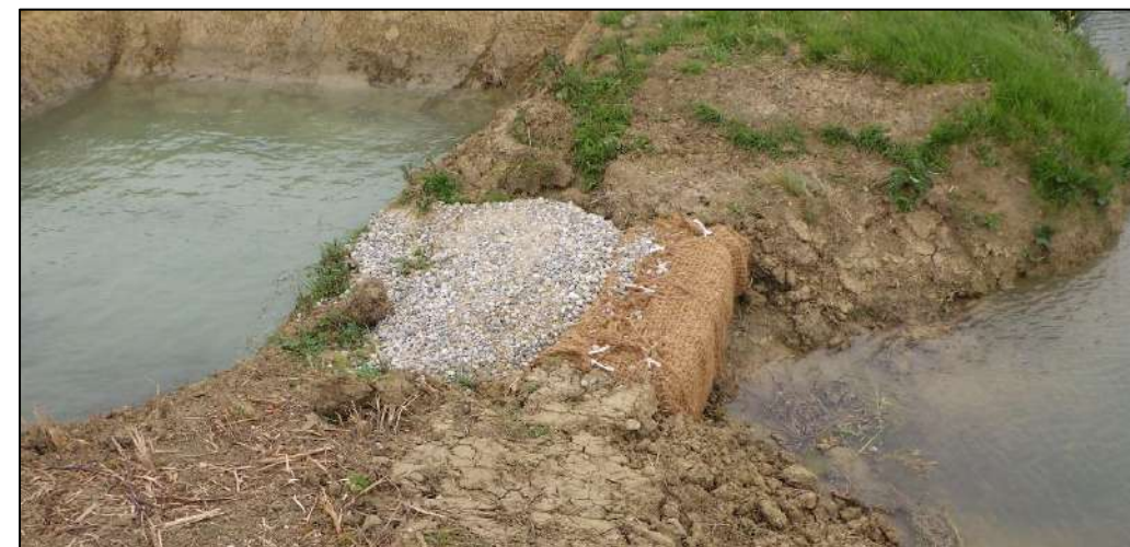
Figure 46 : Illustration d'un dispositif d'assainissement provisoire en phase chantier (filtre à gravier doublé d'un filtre à paille)
