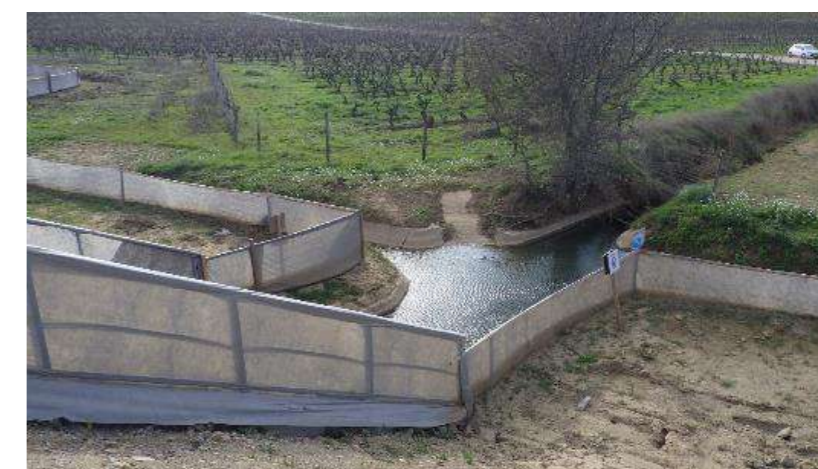
Figure 240 : Clôture anti-intrusion autour d'un cours d'eau (Source : IDE Environnement)
