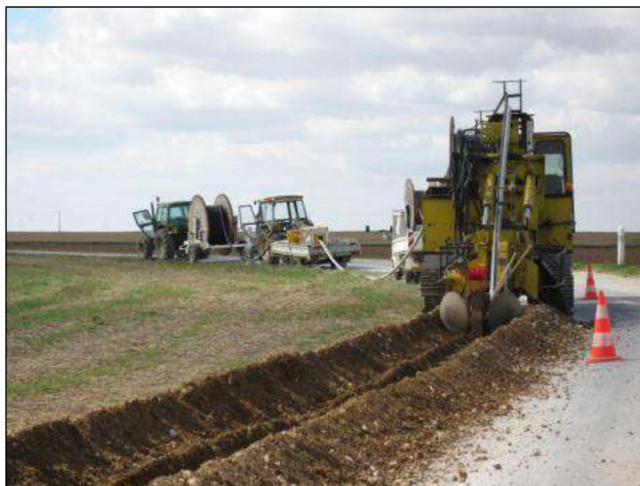
Figure 230 : Illustration des travaux de raccordement réalisés par ENEDIS (source : EDF Renouvelables)
