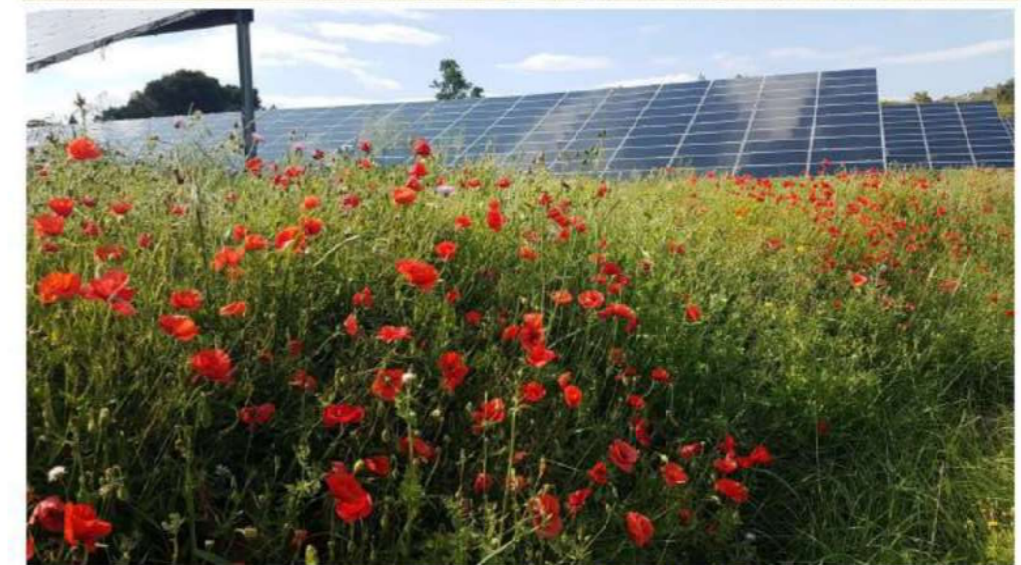
Photo 1 : centrale photovoltaïque de Narbonne (source : SA, 05/2018)
