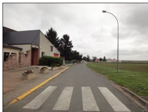
Rue du tour de ville, face aux constructions existantes
