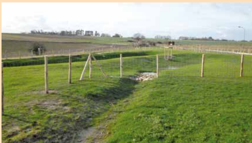
Figure 11 : Un espace pour la rétention des eaux pluviales à proximité d'un lotissement neuf en Seine-Maritime. L'ouvrage, constitué de plusieurs bassins en cascade, permet de rejeter les eaux ruisselées au milieu naturel avec un débit contrôlé. Photo : SMBVAS.
