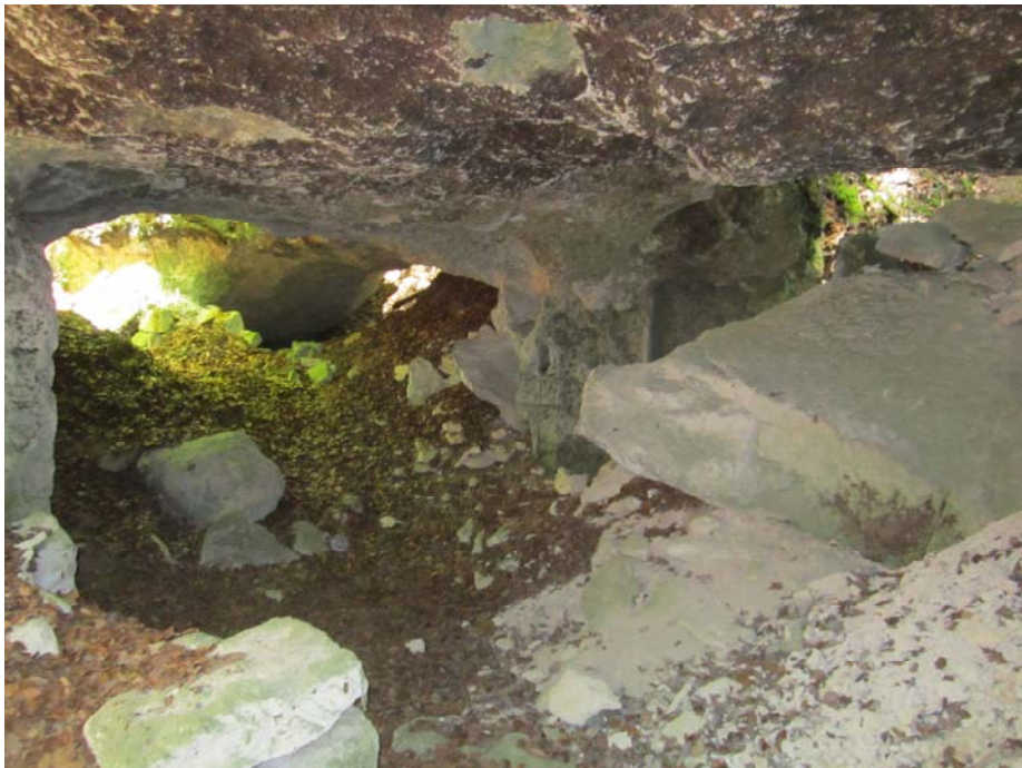
Photo 2 : Exemple d'entrée de carrière du Lutétien à flanc de coteau présentant des instabilités.
