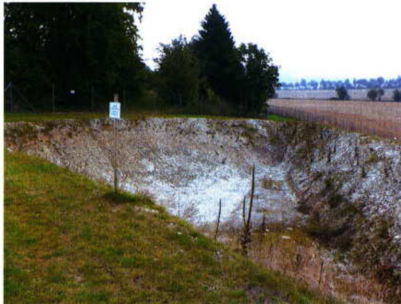
Figure 3 : Photo du bassin d'infiltration des lixiviats traités
