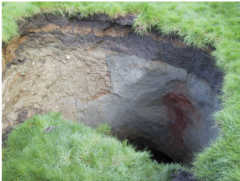
Photo 1 : désordre lieu-dit le Chaufour (2001, photo prise par l'exploitant agricole)
