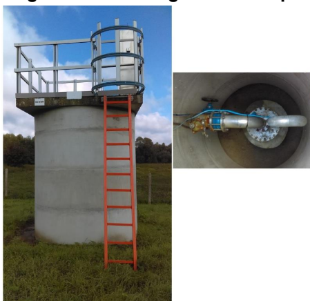
Figure 10 : Tête de forage sur les ouvrages du champ captant de l'Isle Adam
