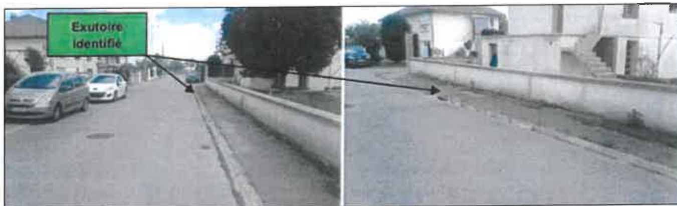
Figure 22 - Exutoires pour les eaux d'exhaure du 17-F-CRA-21
