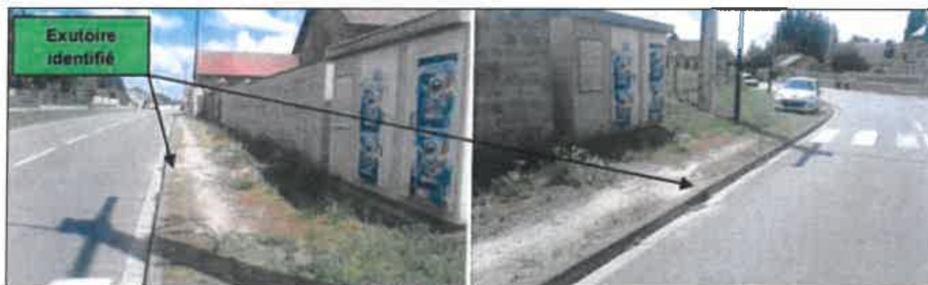
Figure 21 - Exutoires pour les eaux d'exhaure du 17-F-CRA-20
