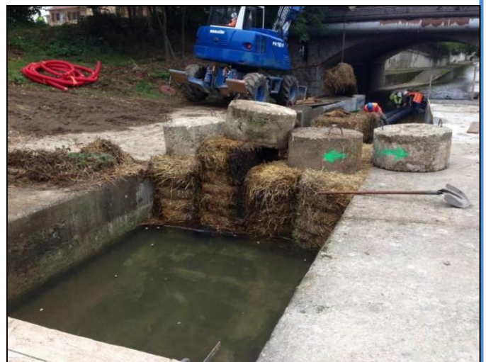
Exemple de bac de décantation sur chantier et de ballots de paille épurateurs avant rejet dans le réseau pluvial ou le milieu naturel
