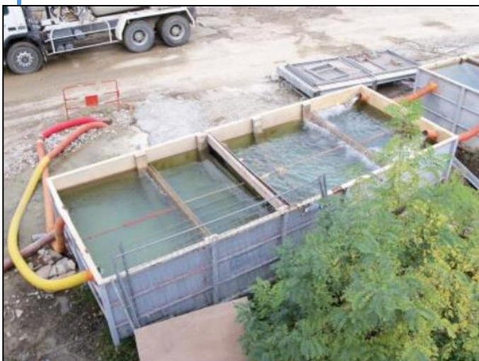
Exemple de bac de décantation sur chantier et de ballots de paille épurateurs avant rejet dans le réseau pluvial ou le milieu naturel
