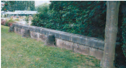
1. Pont sur l'Arré à St-Just
