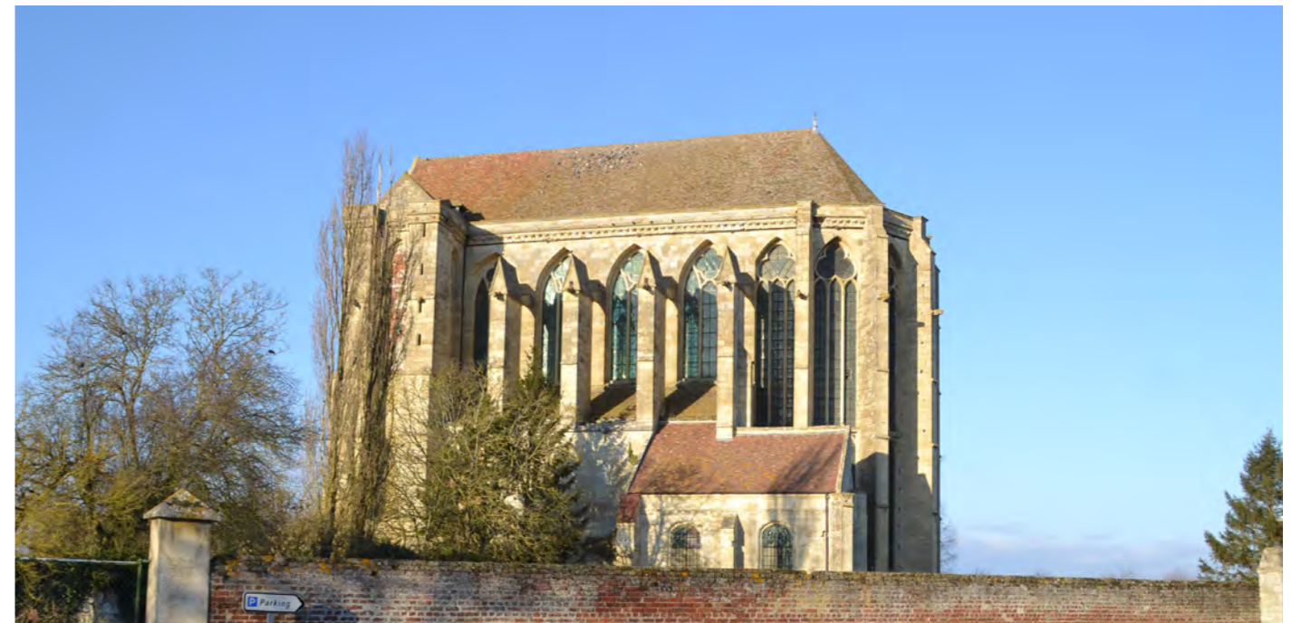
Photo 80 : Église abbatiale de Saint-Martin-aux-Bois
