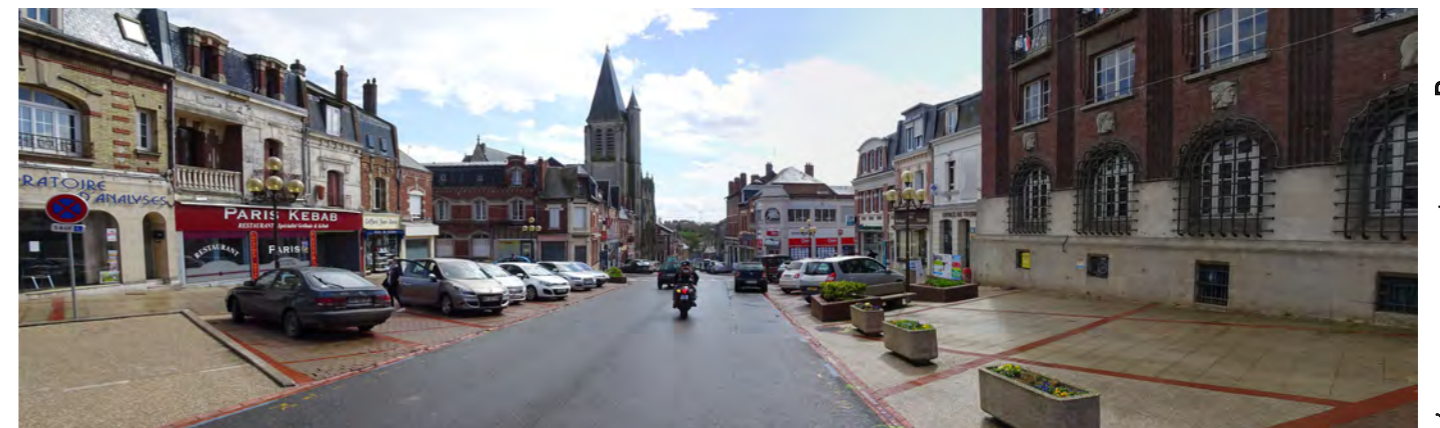
Photo 74 : Vue en direction du projet, aux abords de l'édifice
