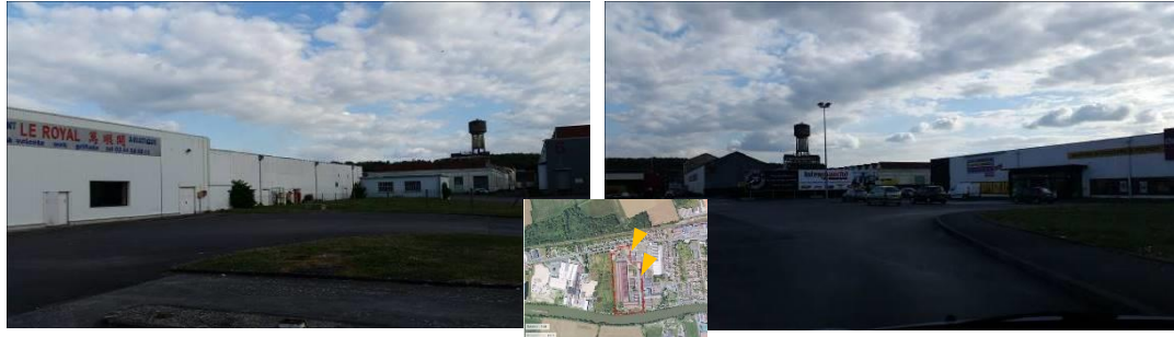
Figure 4-6 : Vue du site Terbis depuis la zone commerciale
