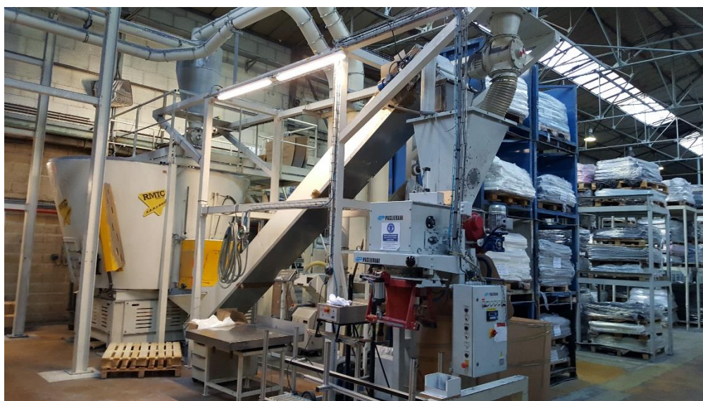
Photo 2. Bât. N – Unités de broyage des chutes de PVC
