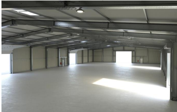
Photo 5. Vue intérieure du bâtiment démontable (rub. 2663-2).
