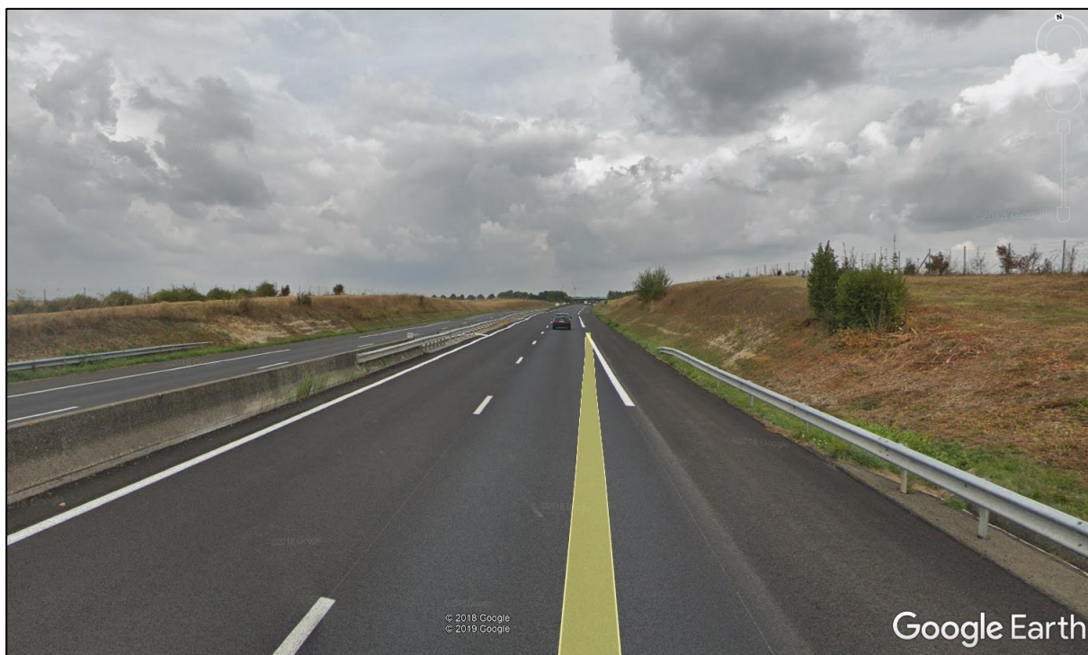
Autoroute A16 – Présence de barrières de sécurité et de talus
