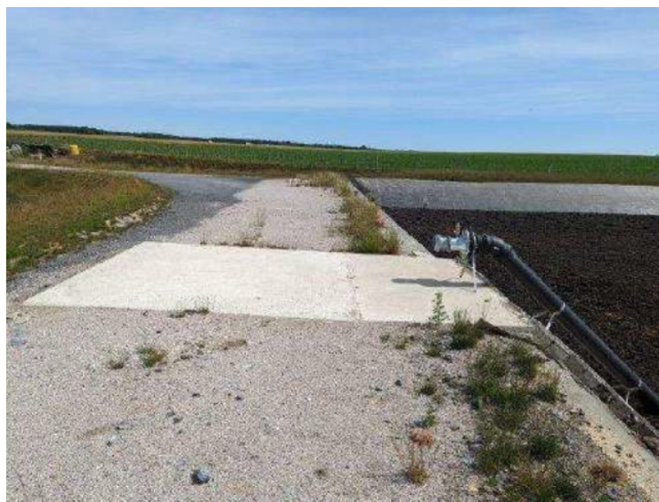
Tuyau de pompage « Fosse Paquette »
