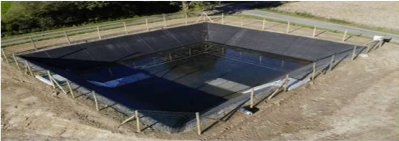
Modèle avec clôture pour les lagunes extérieures
