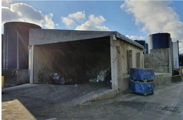
Figure 2 : Vue de l'alvéole C0 suite aux travaux de couverture
