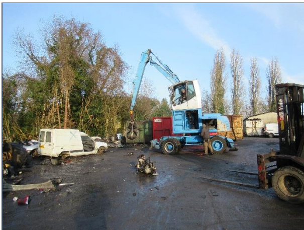
Photo 1 : Grappin en manœuvre sur aire étanche
