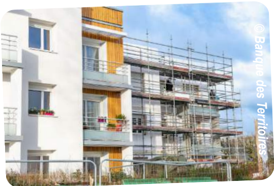
Les opérations de rénovation énergétique de l'habitat social devraient aussi viser l'amélioration de l'habitabilité des logements, en offrant un plus grand confort acoustique, une bonne qualité de l'air intérieur ainsi qu'une valorisation sociale. © BdT
