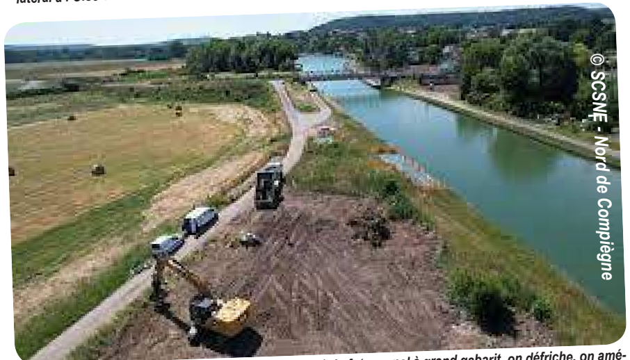
Au nord de Compiègne, dans l'Oise, sur le secteur 1 du futur canal à grand gabarit, on défriche, on aménage le premier quai de transbordement, on prépare les accès routiers, avant le démarrage du chantier de creusement.
