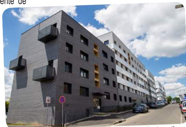
Réhabilitation du Clos-Saint-Antoine dans le quartier Argentine, financée par l'ANRU et inaugurée en juillet 2022 (SA HLM 60)
