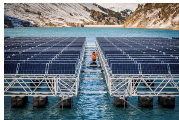
Flotteurs individuels et radeaux modulaires (source : Romande Energie)
