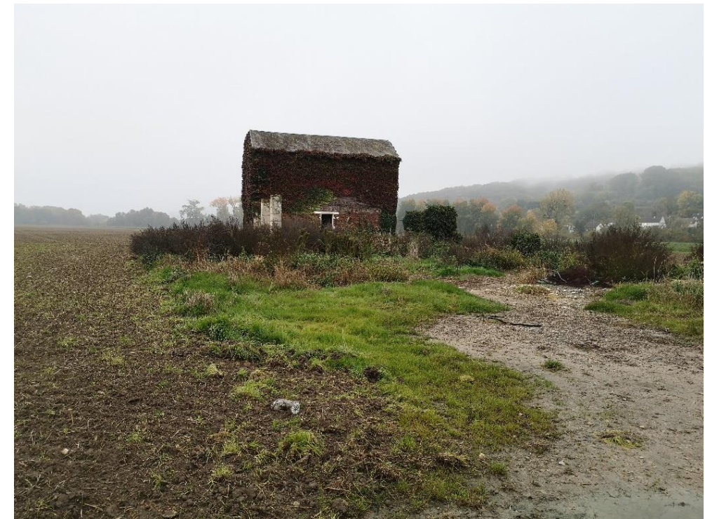
6) Construction à l'abandon au sud de l'aire d'étude
