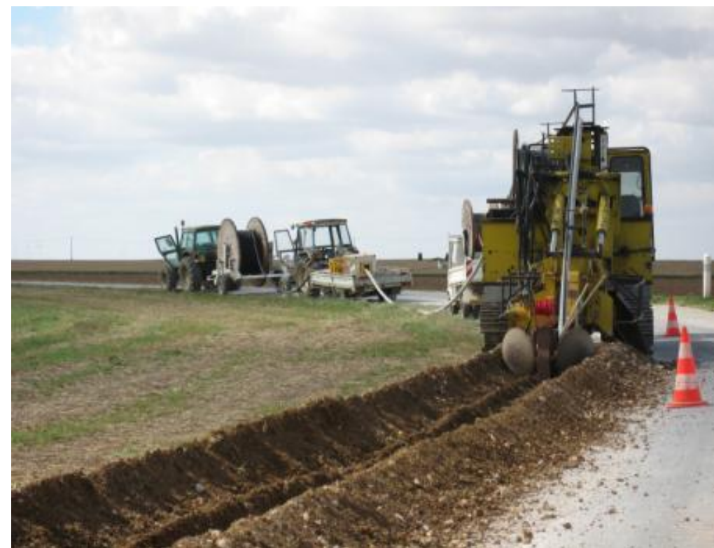
Illustration des travaux de raccordement réalisés par ENEDIS (source : EDF Renouvelables)
