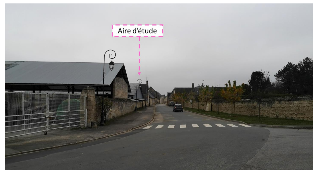
32) Vue depuis la rue principale de Bitry (rue du vieux moulin) au niveau de l'église, à environ 1,1 km au nord du site (visibilité nulle)
