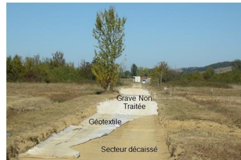
Mise en place d'une voie engins (lourde)
