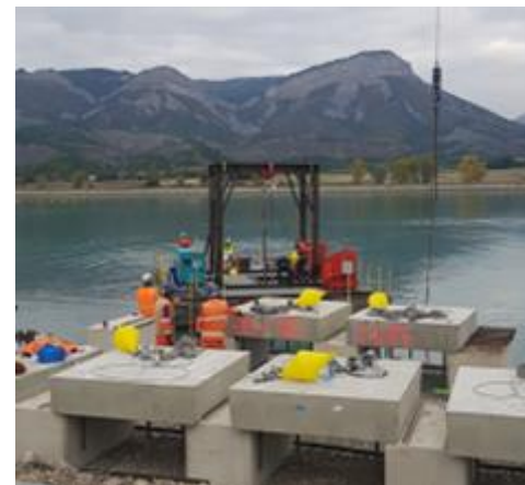
Mise en place des ancrages type poids-mort au fond de l'eau – Source : EDF renouvelable
