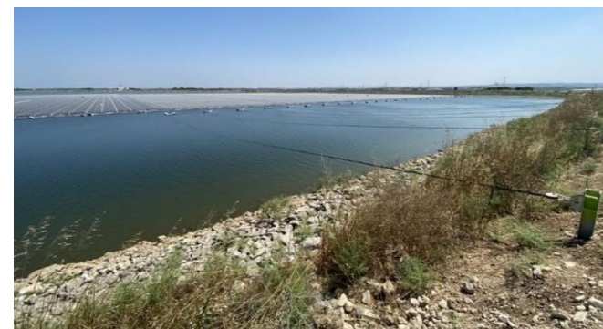
Ancrages au berges par pieux battu et Spinnakers - source : EDF renouvelable
