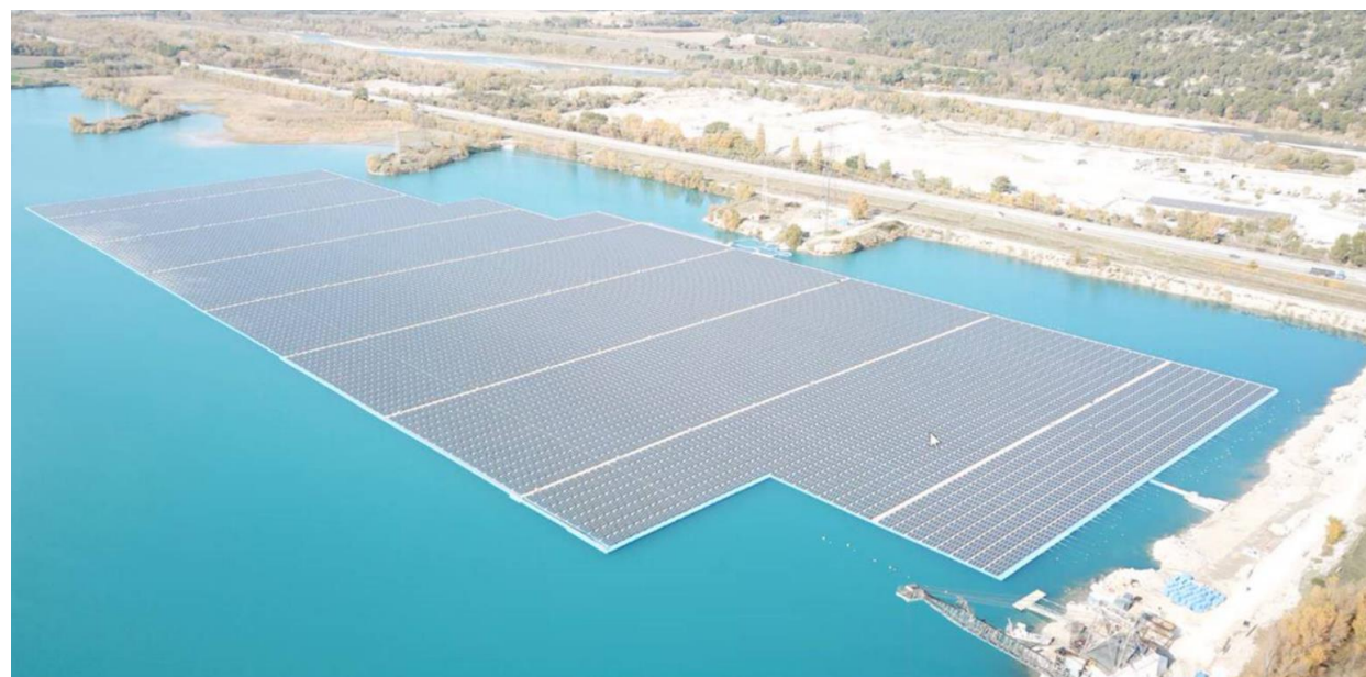
Centrale photovoltaïque de Boralex à Peyrolles en Provence (Source : EDF Renouvelable)
