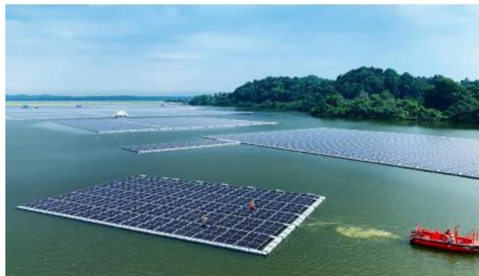
Assemblages de blocs en ilots (source : INES)
