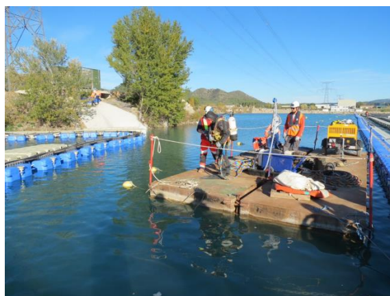
Contrôle des ancrages au fond du réservoir – Sources : Luxel
