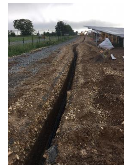
Tranchée pour la pose des câbles enterrés – source : LUXEL
