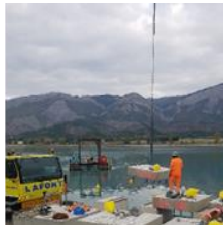
Mise en place des ancrages type poids-mort au fond de l'eau – Source : EDF renouvelable
