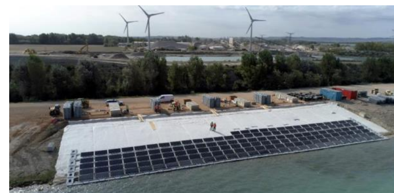
Assemblage des flotteurs individuels - source : EDF renouvelable
