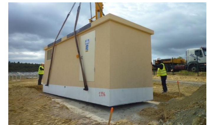
Schéma de dépose des postes préfabriqués - Source : Transfix Photo de pose de poste préfabriqué
