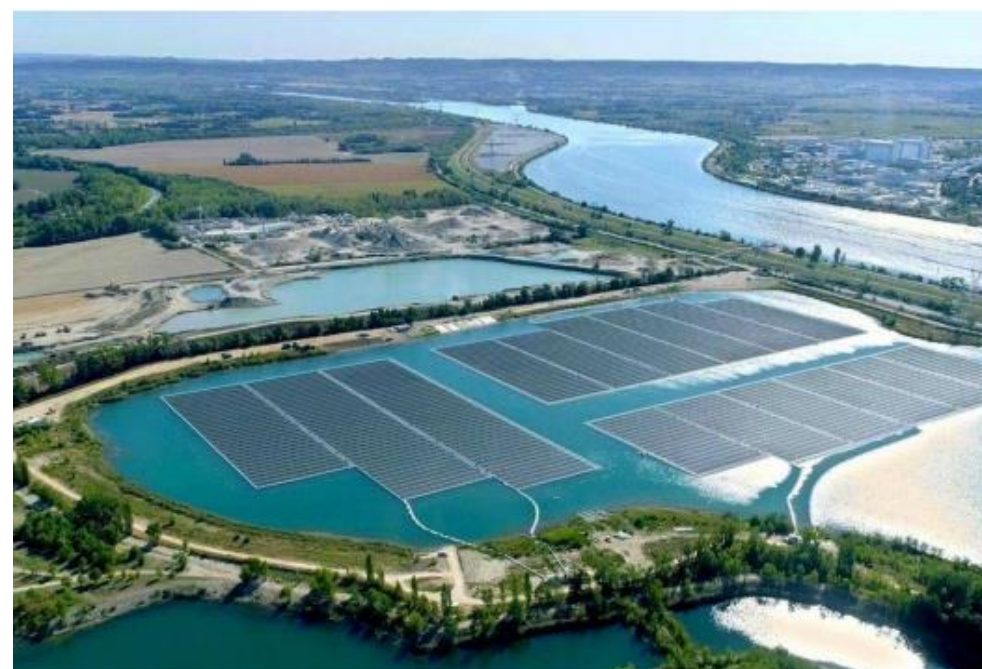
Adaptation de la forme des ilots au relief (source : INES)
