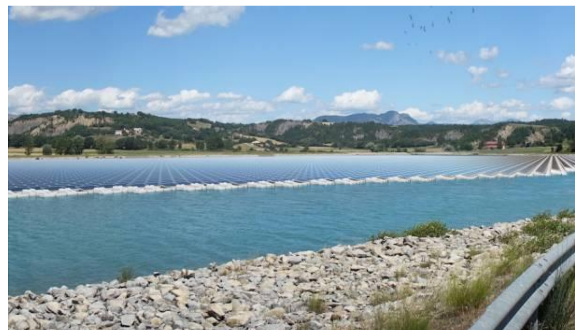
Centrale photovoltaïque de Lazer dans les Hautes-Alpes (Source : EDF Renouvelable)
