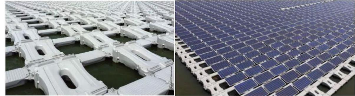
Les flotteurs technologie Hydrélio en HDPE – source EDF Enr
