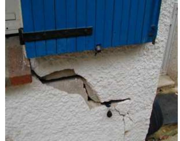
Sous une maison, l'évaporation ne peut se produire qu'en périphérie. Il apparaît un gradient entre le centre du bâtiment (équilibre hydrique) et les façades, et par suite des mouvements différentiels. Contrairement aux phénomènes de tassement par consolidation les effets ne s'atténuent pas avec le temps mais augmentent quand la structure perd sa rigidité.
