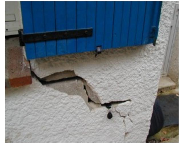
Principaux facteurs de vulnérabilité : rigidité insuffisante, fondations trop superficielles, dallages sur terre-plein, arbres proches, réseaux enterrés fuyards.
