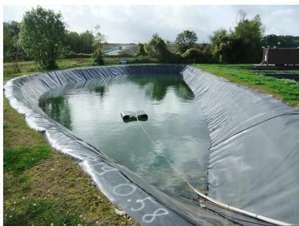
Figure 38 – Vue du bassin de stockage des perméats
