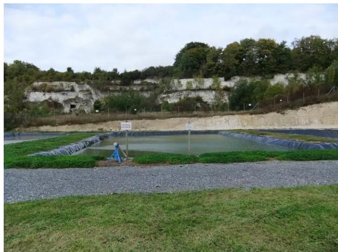
Figure 32 – Vues des bassins de gestion des eaux de ruissellement (bassin de filtration et bassin de décantation)
