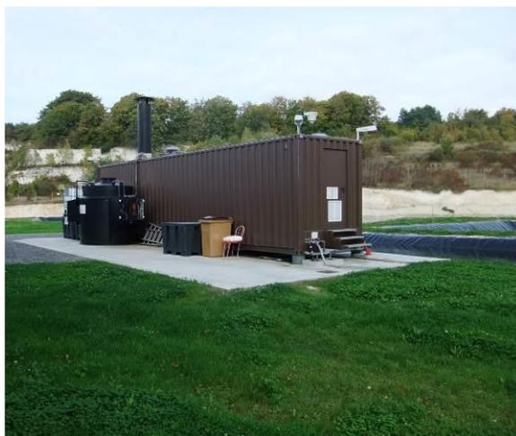
Figure 36 – Photo de l'unité mobile de traitement des lixiviats par osmose inverse
