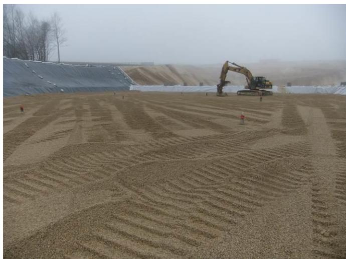
Figure 17 – Vue de la mise en œuvre du drainant en fond de forme
