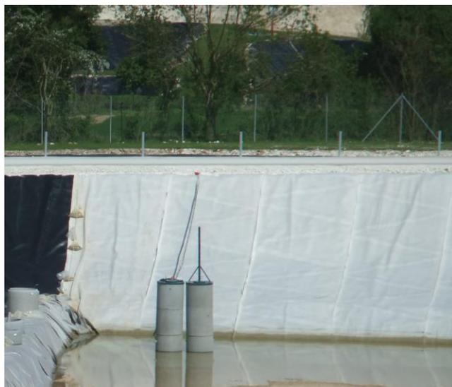
Figure 33 – Photos des puits de pompage et de contrôle
