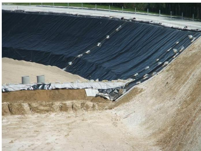
Figure 18 – Vue des travaux d'aménagement du casier 1 avec talus géomembrané
