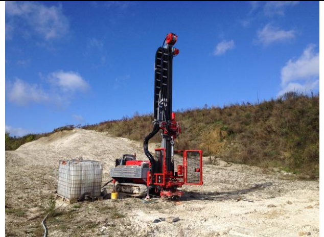
Atelier SOCOMAFOR 65 sur SD6
