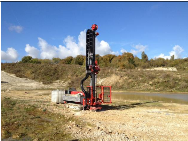
Atelier SOCOMAFOR 65 sur SD4
