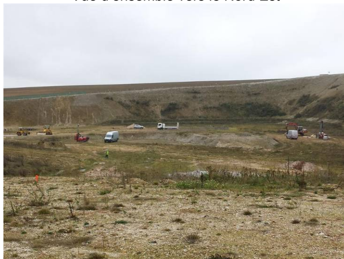
Vue d'ensemble vers le Sud
