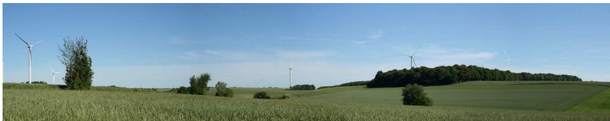
Photo 3 : Parc éolien de Blicourt/Lihus en construction
