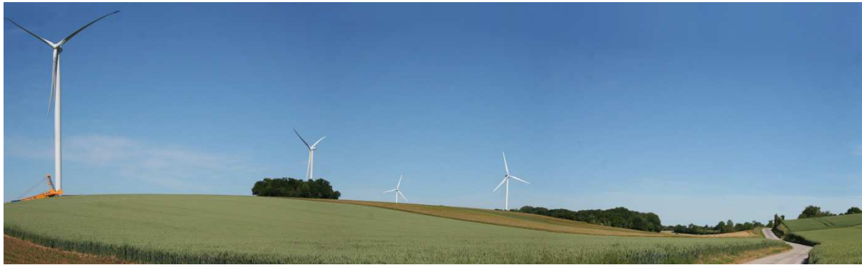
Photo 2: Parc Eolien de Blicourt/Lihus en construction
