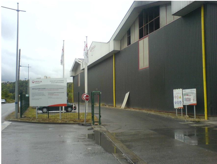
Photo de l'entrée du site et du bâtiment de tri
