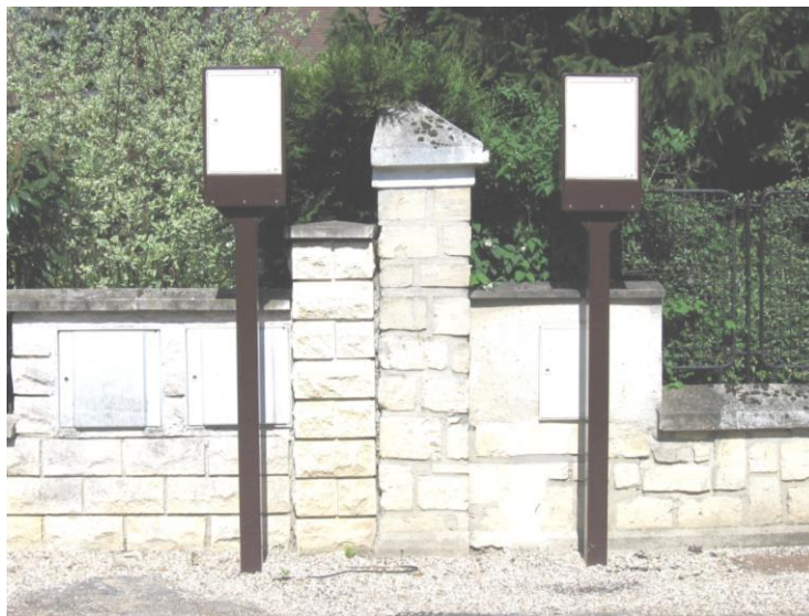
Photographie 13 - Rehausse des compteurs électriques à Jouy-le-Moutier (95)
