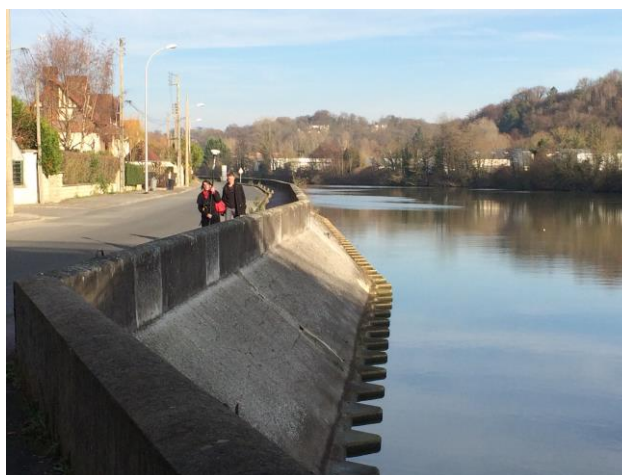
Photographie 18 - Les murets de protection de Creil (60)
