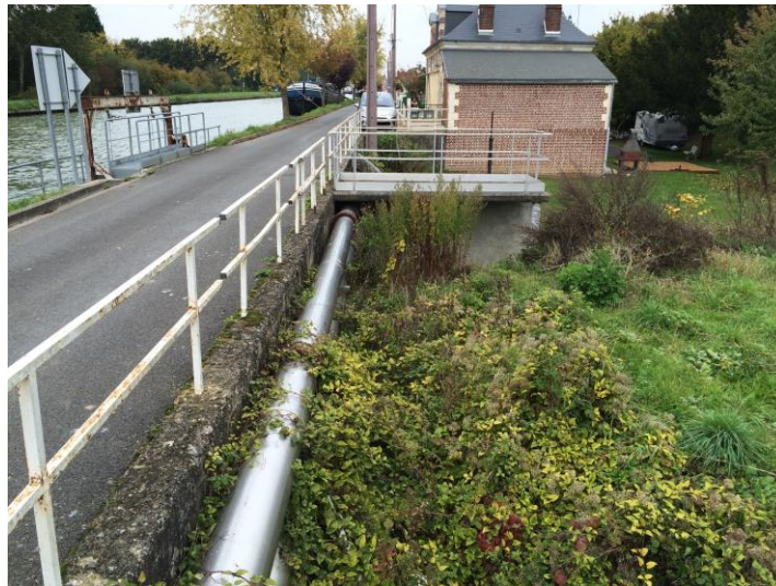
Photographie 19 - Canal latéral à l'Oise et système de vannage à Thourotte (60)
