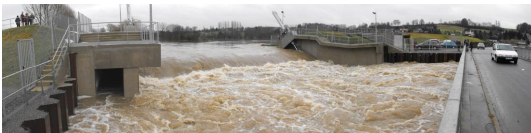
Photographie 9 - Régulation de la crue de janvier 2011 à Proisy (EOA, 2011)
