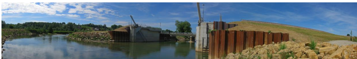
Photographie 15 - Le site d'écrêtement des crues de Proisy
