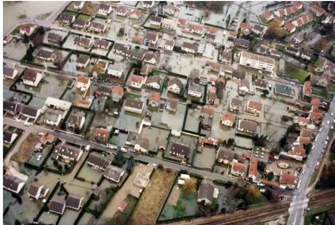
Photographie 8 - Quartier du Marais à Persan (95) lors des inondations de février 1995 (photo d'archive)
