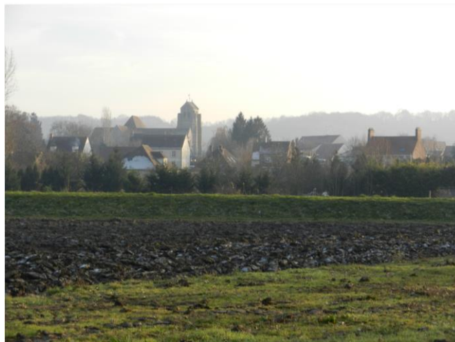
Photographie 17 - Digue de Verberie (60)
