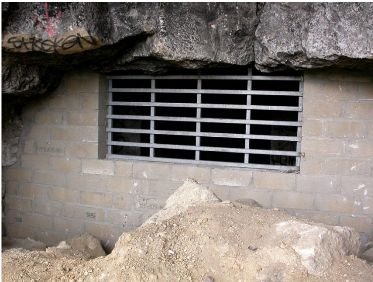
Grille avec assise en parpaing sans accès
