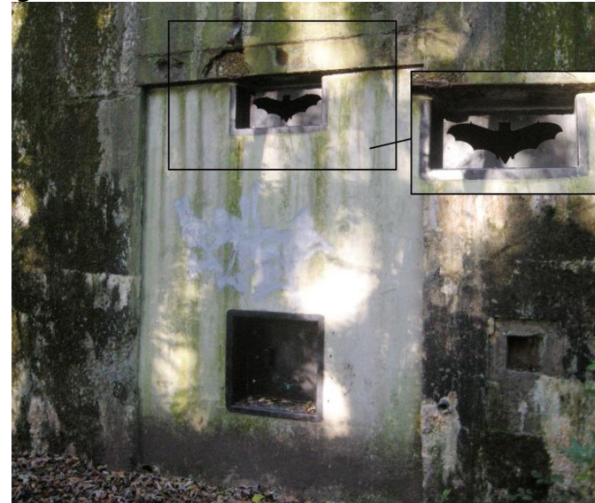
Ouverture type lucarne avec point d'accès en partie basse
