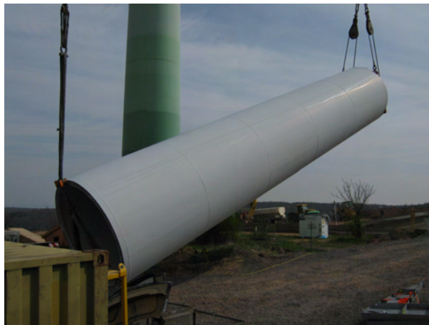
Figure 16: Déposer la section du mât
