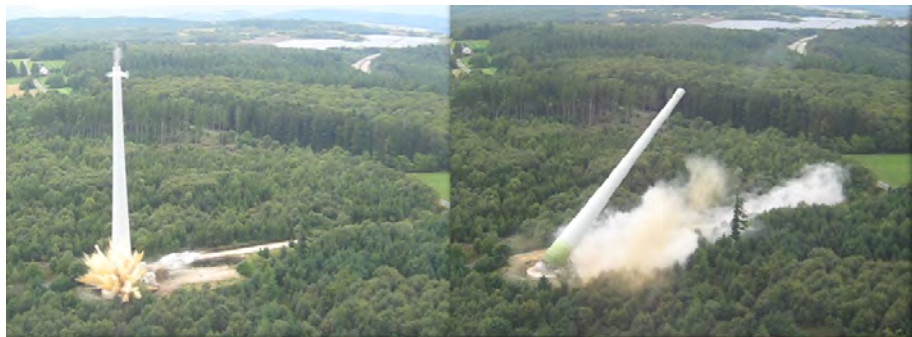
Figure 6: Dynamitage du mât en béton d'une éolienne
