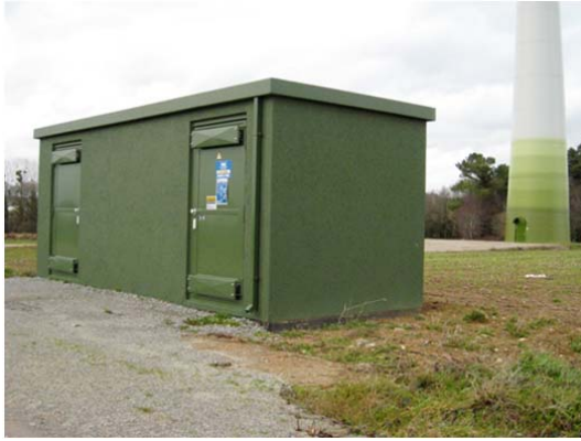
Figure 20 : Poste de livraison type ENERCON
