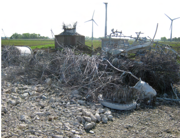
Figure 17: Armature en béton et en acier séparée
