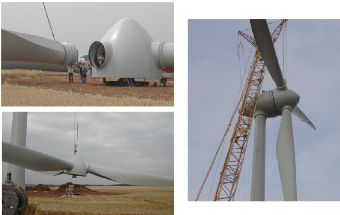
Figure 4 : Assemblage et montage d'un rotor ENERCON
