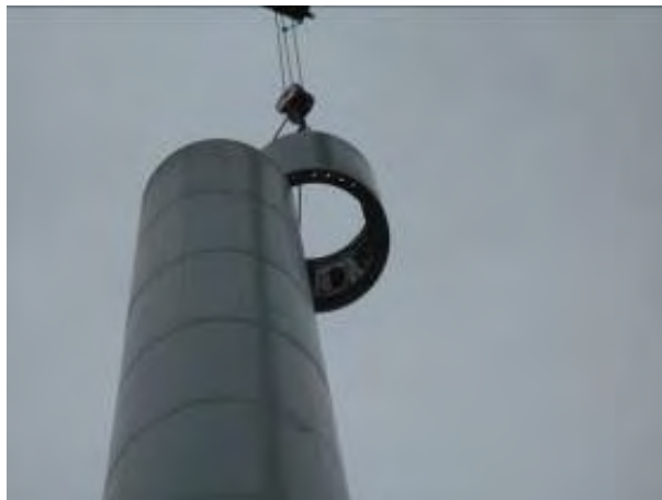
Figure 13: Utilisation de points d'attache présents pour enlever une section
