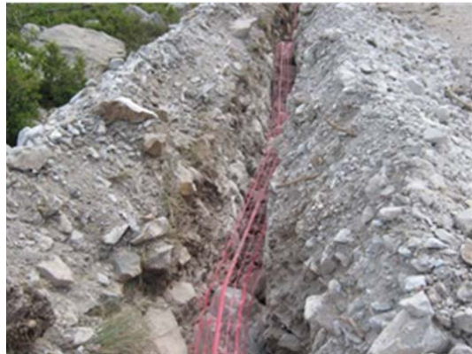
Figure 18 : Passage de câbles
