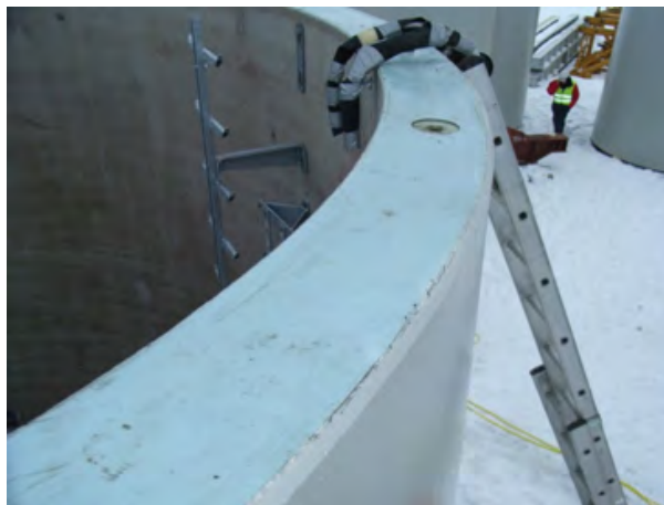
Figure 4: Le joint horizontal est aplanie avec de la résine époxy et les sections sont placées les unes au-dessus des autres sans être collées
