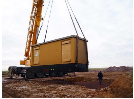
Figure 20 : Poste de livraison type ENERCON
