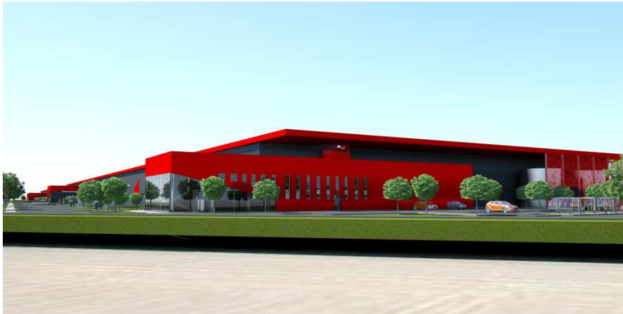
Figure 18 : vue du bâtiment B depuis son entrée
