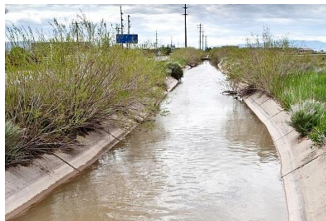
Un fossé maçonné sur le terrain
