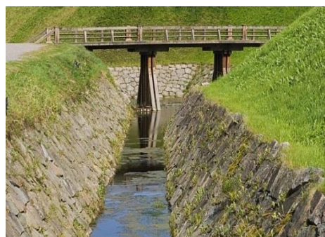
Un fossé maçonné sur le terrain
