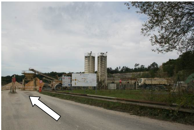
Voie d'accès au site (apport de remblais extérieurs)
