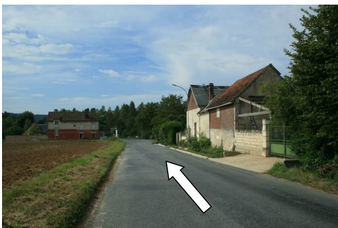
Voie communale n°5, à hauteur du Lieu-dit « La Grenouille », juste avant l'intersection avec la RD 15 et la RD 142
