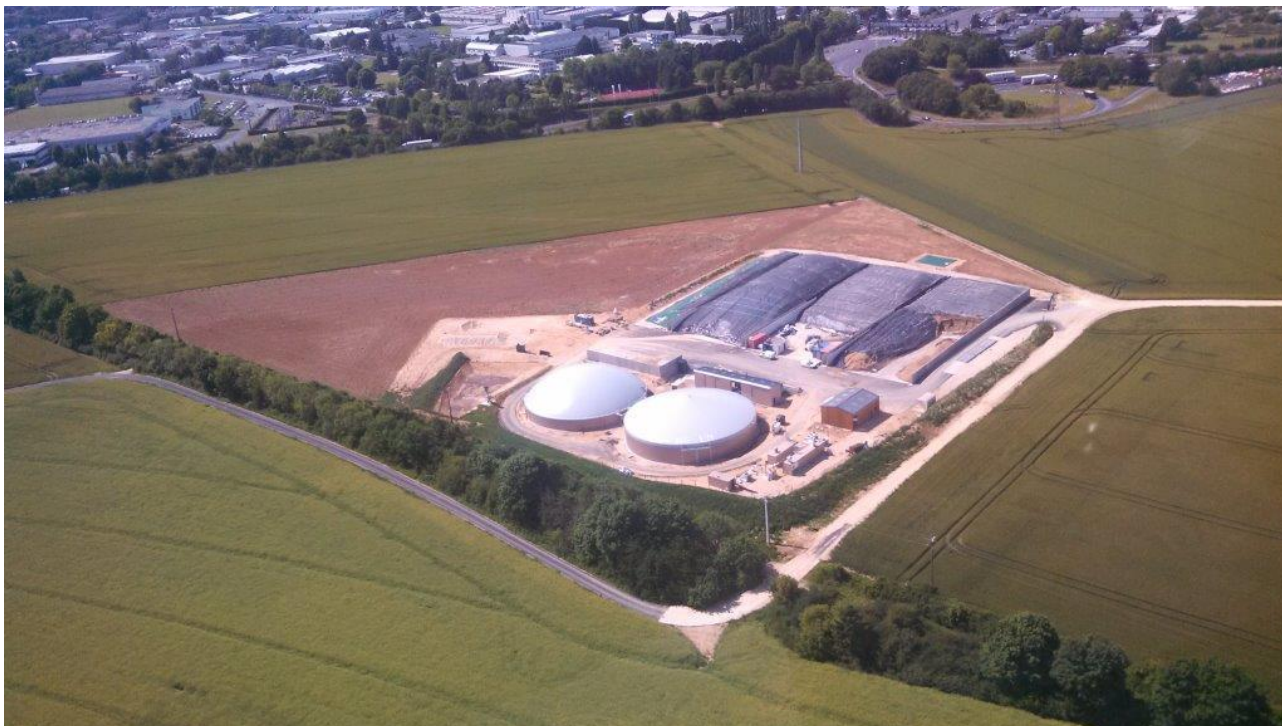
Figure 4 : Photos du site en fin de construction (printemps 2017)
