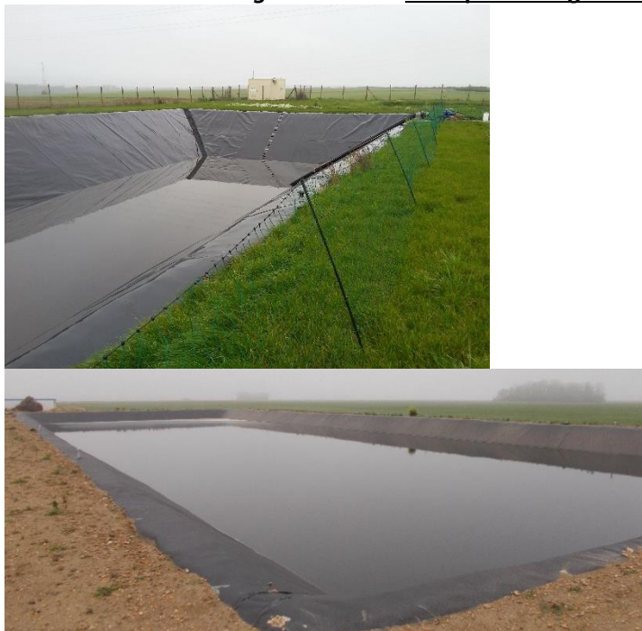
Figure 1 : Exemples de lagunes de stockage de digestat
