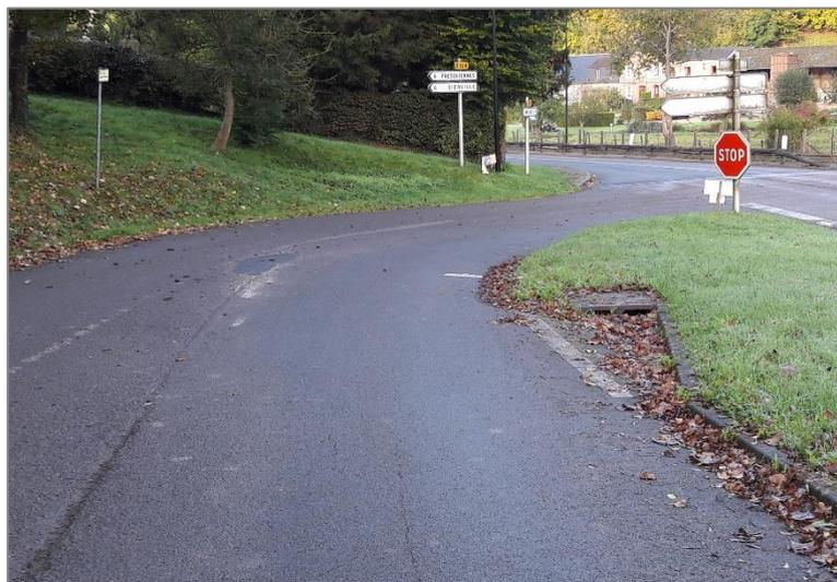
**Photo n°2 Illustration d'un avaloir perpendiculairement aux écoulements**
