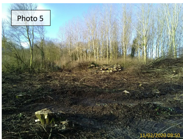
Photo 5 : Parcelle 39 déboisée, facilitant l'accès et l'aménagement du méandre.
