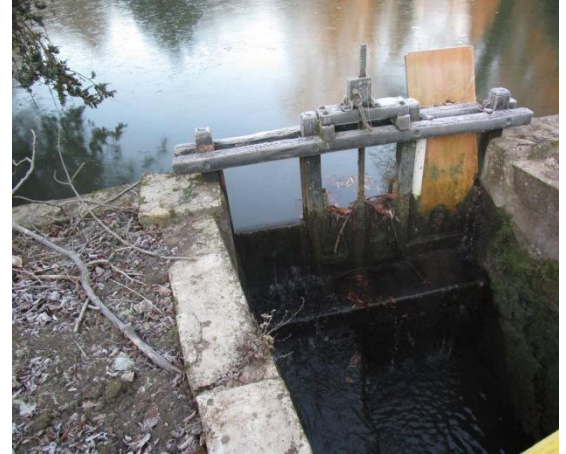
Figure 40 : Vannage du château aval de Betz
