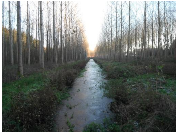
Figure 51 : Canal stagnant de la Grivette
