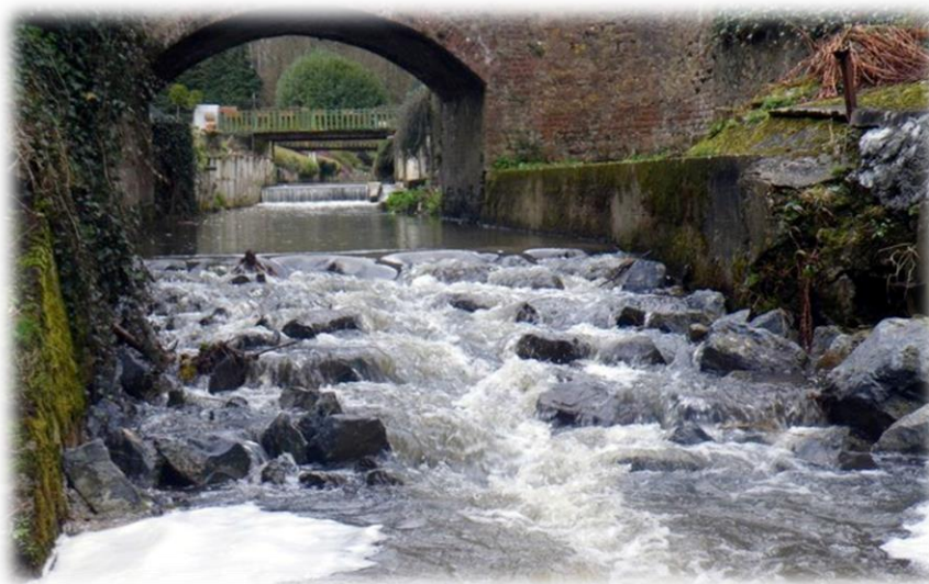
Figure 41 : Exemple de rampe rustique
