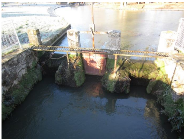
Figure 30 : Ouvrage Gr3, vannage des plans d'eau du Parc de Betz
