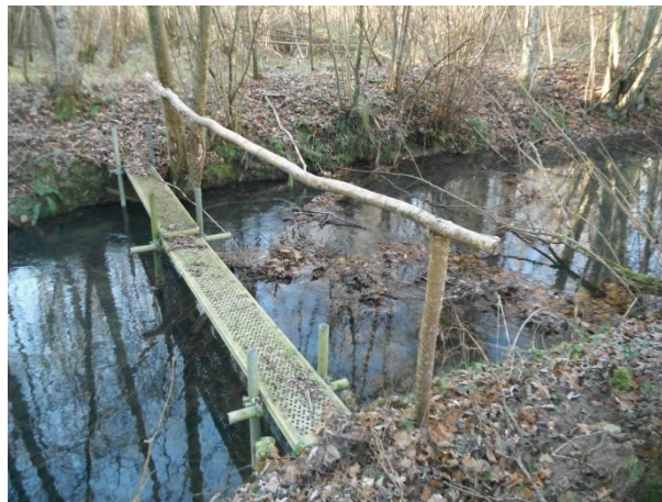
Figure 29 : Embâcles dans une passerelle
