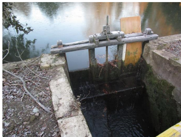
Figure 31 : Ouvrage Gr4, vannage du plan d'eau du château aval de Betz
