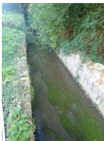
Berges en murets de pierres sur le bras de source
