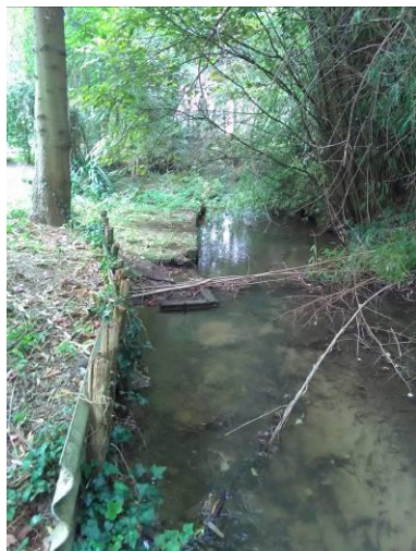
Protection de berge sur la partie aval du camping
