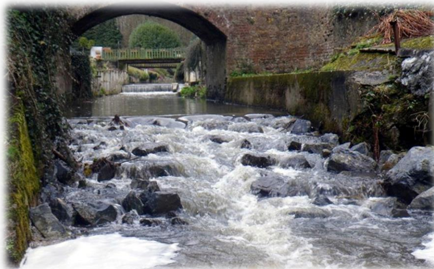
Figure 14 : Exemple de rampe rustique
