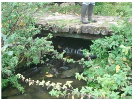
Rehausse du seuil en aval du Chemin de Vincy (G8)
