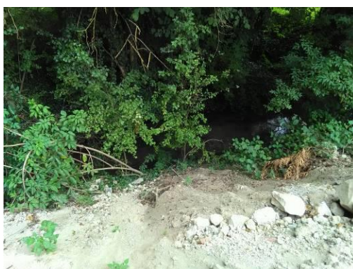
Berge en remblais
