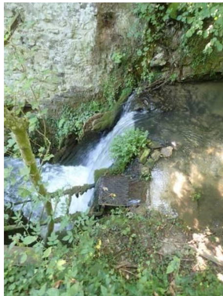
Figure 13 : Chute du seuil du moulin de May
