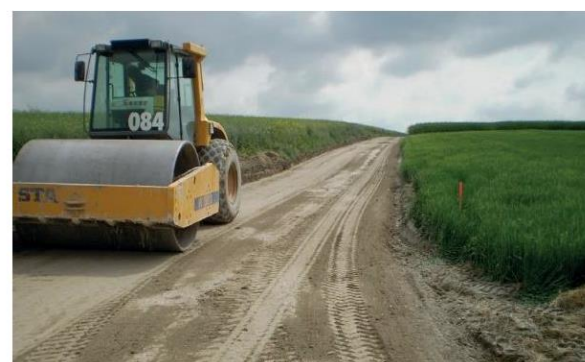
Figure 107 : Exemple d'aménagement d'un chemin d'accès, grave compactée sur géotextile
