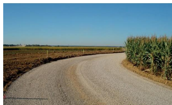
Figure 107 : Exemple d'aménagement d'un chemin d'accès, grave compactée sur géotextile
