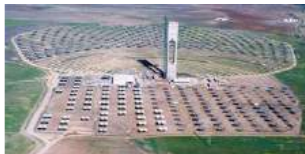
Les tours solaires (photo : centrale à héliostat de 35 MW à Séville en Espagne)
