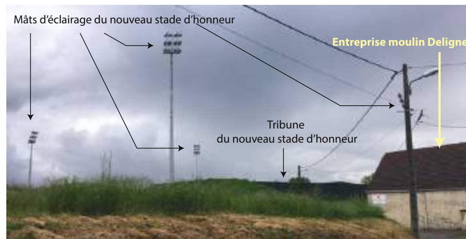
Vue sur le site d'étude depuis la rue du Moulin - Source : MA-GEO, 18 mai 2021
