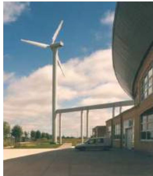
Eolienne à axe horizontal du lycée Léonard de Vinci à Calais hauteur 35 m, puissance 132 kW (source : ARENE)
