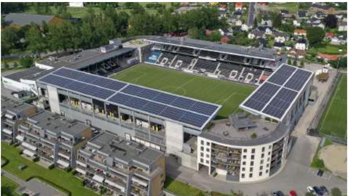
Installation photovoltaïque sur les tribunes du Skagerak Arena en Norvège (puissance de 800 kWc)
