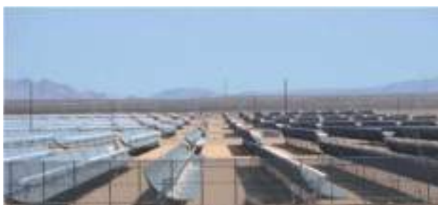
Les centrales à capteurs cylindro-paraboliques (photo : centrale LUZ en Californie de 354 MW)
