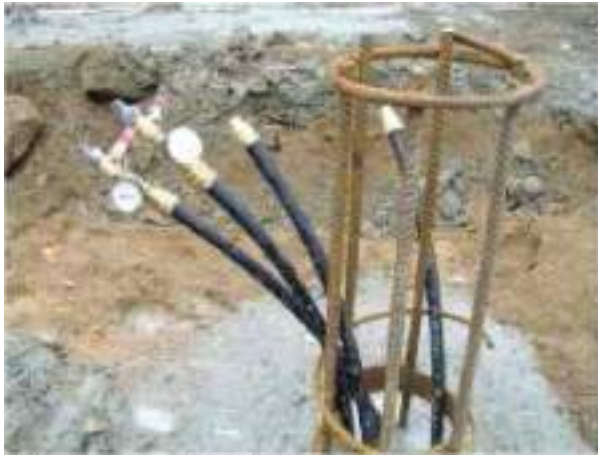
Tubes et armatures en tête d'un pieu (source : PREBAT)
