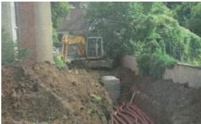
Réseau du puits canadien avant remblaiement (source : Canada Clim)
