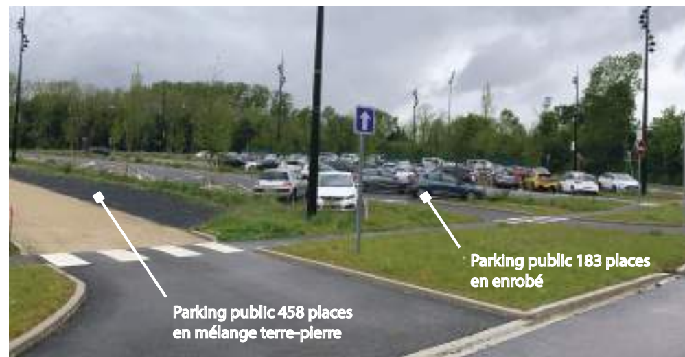
Parking en rive droite Source : MAGEO - visite du 18 mai 2021
