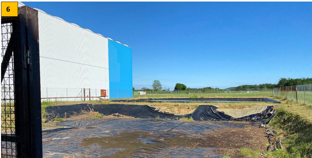
Photo 8 – Premier plan ancien réservoir perméable après la destruction de la bâche. A l'arrière-plan, réservoir toujours en eau
