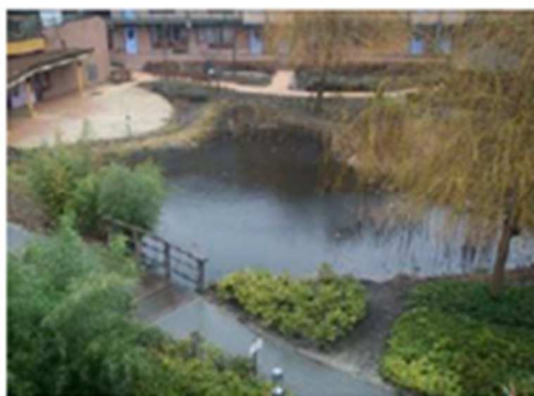
Figure 44 : Marre d'infiltration (Rombaut, 2010)
