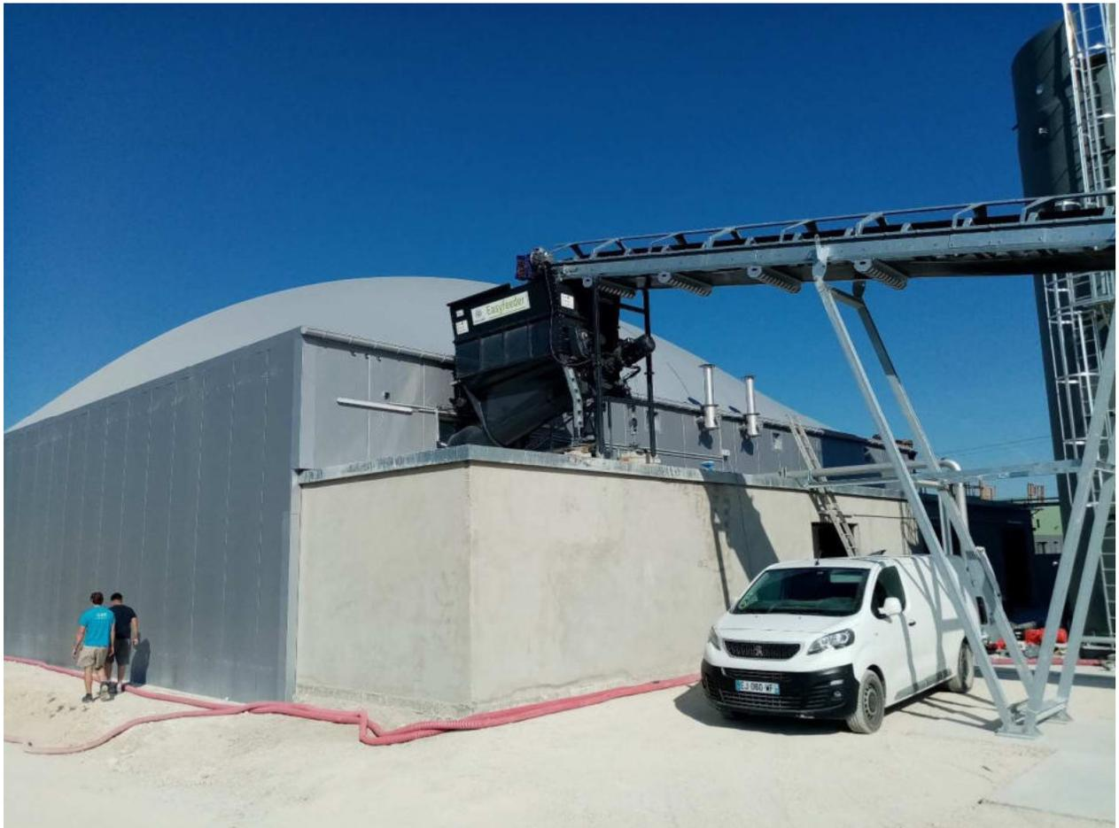
*Digesteur en voie sèche continue (source : CH<sub>4</sub> Systèmes) ; la trémie d'incorporation est visible au premier plan*
