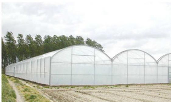
Pour la culture en bassin, il faut considérer des serres qui occupent une surface d'environ 1000 à 1 300 m<sup>2</sup>. Les serres abritent 4 bassins de 210 m<sup>2</sup> environ, soit une superficie totale de bassin de 840 m<sup>2</sup>. Chaque bassin, avec une profondeur d'eau de 0,3 m, abritera un volume d'eau total de 63 m<sup>3</sup>, la profondeur du bassin pouvant être ajustée. Le milieu est rendu turbulent par le fonctionnement d'une roue à aube.
