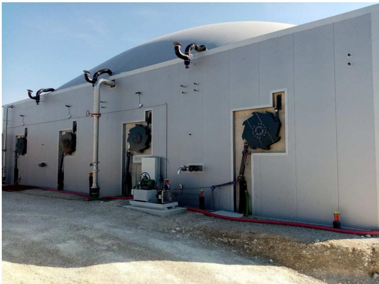
*Façade d'un digesteur en voie sèche continue avec les roues d'entraînement des mélangeurs longitudinaux (source : CH<sub>4</sub> Systèmes)*
