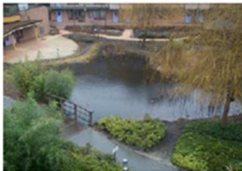
Figure 44 : Marre d'infiltration (Rombaut, 2010)
