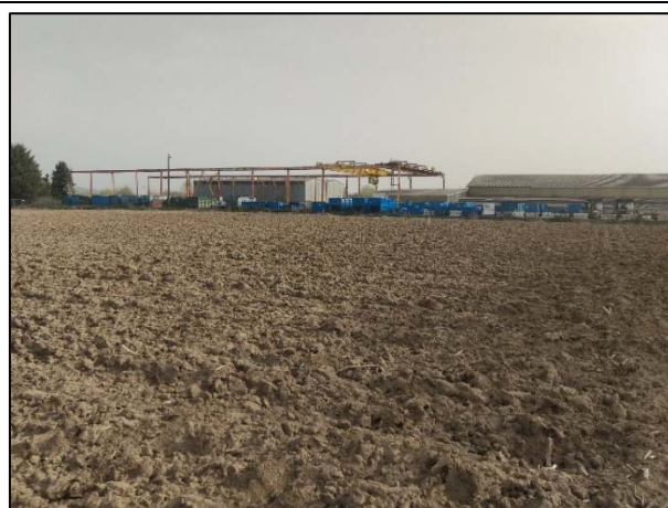
Vue n°4 : Sud-Ouest vers Est
